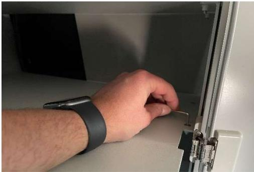
8. Regalboden leicht festschrauben (erst alle Böden leicht festschrauben, sollte eine Halterungen etwas versetzt angebracht sein, kann diese durch leichtes Drücken oder Schieben einfach ausgeglichen werden)
