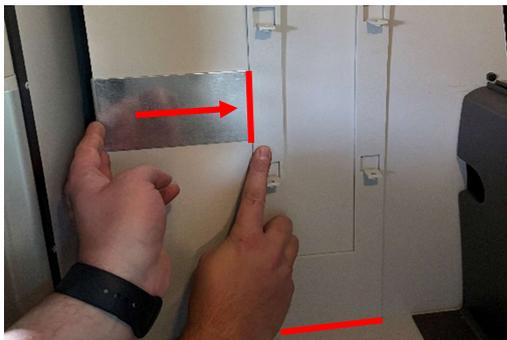
3. Position der Halterung links: Halterung auf dem Boden aufstehen lassen, Montagehilfe am linken Schrankende anlegen und Halterung bis an die Montagehilfe schieben, Halterung an vorgesehener Position fest andrücken
